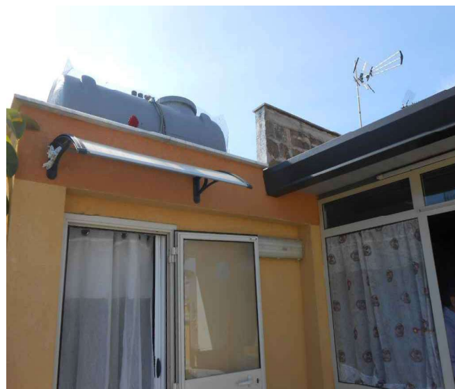
34. Piano 3°, Terrazza. A sinistra il torrino scala di arrivo della scala a chiocciola con solaio piano con serbatoio acqua potabile da 1000 lt, a destra la veranda.
