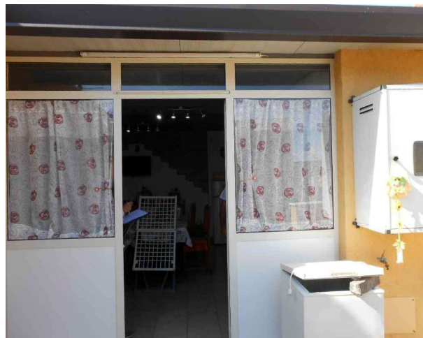
32. Piano 3°, Terrazza. La veranda. A destra la caldaia a gas
